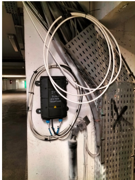
Sous le bâtiment B
